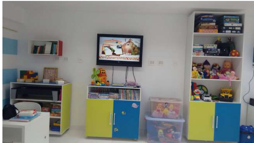
Figura 3 – Resultado final da reforma da sala vista 01.
