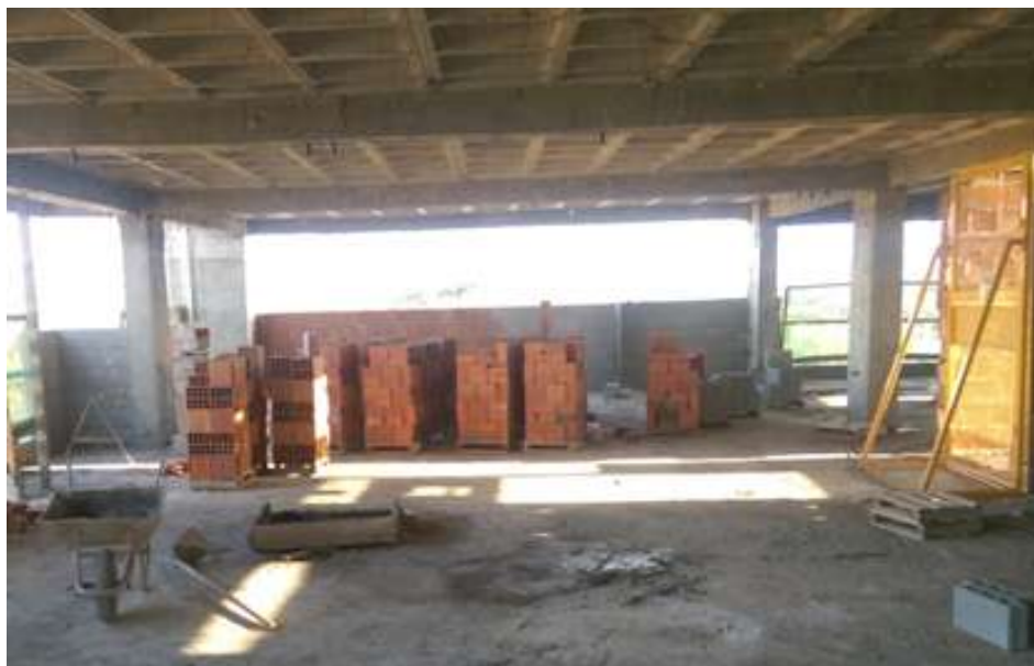
Figura 2 – Armazenamento de blocos cerâmicos.
